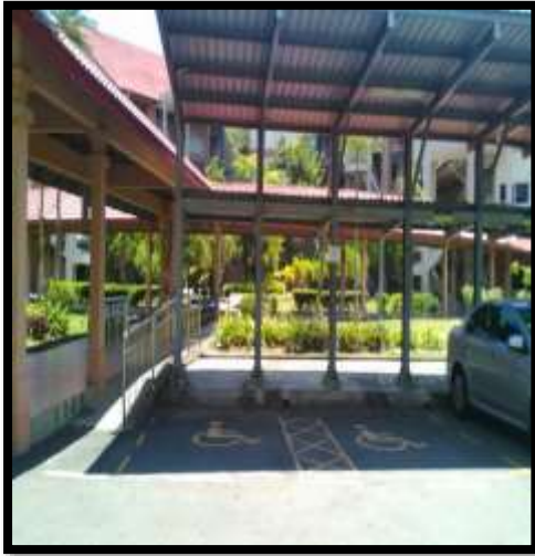
Tempat meletak kenderaan OKU dikhaskan dan diletakkan berhampiran dengan laluan yang memudahkan pengguna OKU
